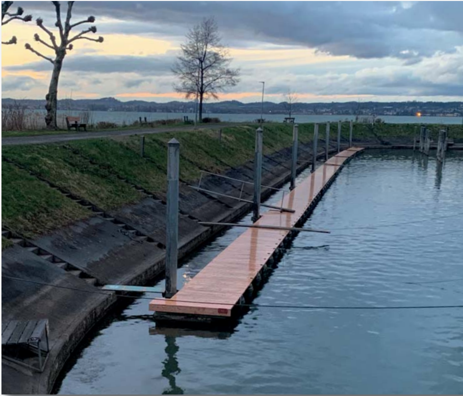
Perfekte Arbeit: Neue haltbarere Unterkonstruktion und neuer Stegbretterbelag.
